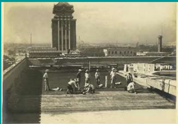
屋根防水層施工状況（県庁写真）
